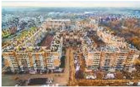
ЖК «Новое Яино», Ленинградская область ГК «ЦДС»
