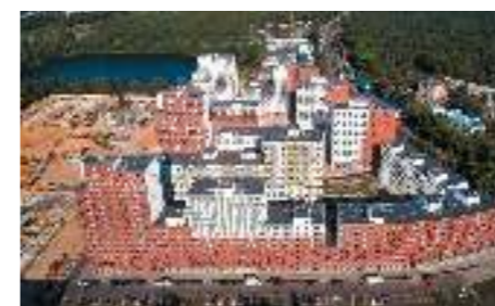
ЖК «Новокрасово», МО «Тройка РЭД»
